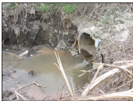
а) испуштање на отпадни води од инсталацијата во собирен канал.
